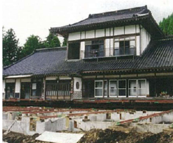
【建物定着前の現場】
