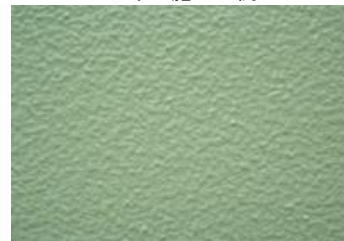
ローラー施工の例
