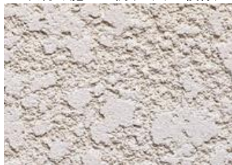
吹付け施工の例(スタッコ模様)
