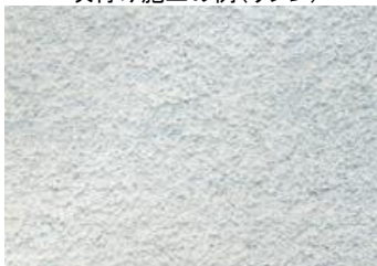
吹付け施工の例(リシン)
