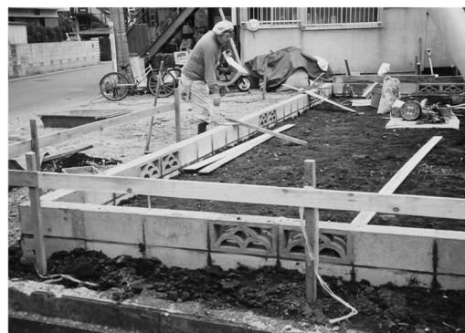
【空洞ブロック積の現場】
