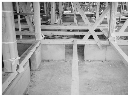
【防湿コンクリート叩き打設後の現場】
