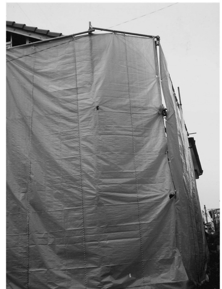
【仮設防災防止シート張現場】
