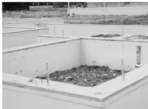
【布基礎天端モルタル均し後の現場】
