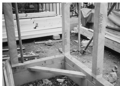
【下層横架材（土台・火打土台）】
