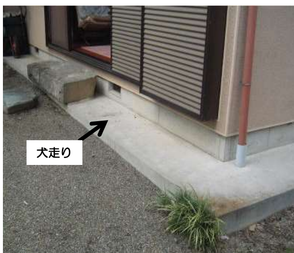
【土間コンクリート打設後の現場】
