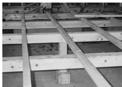
【大引・根太の施工現場】
