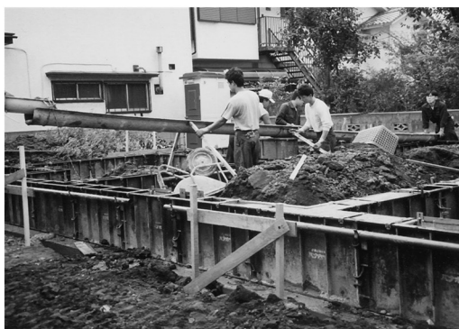
【布基礎コンクリート打設の現場】
