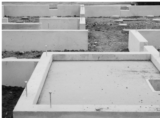
【土間コンクリート打設後の現場】
