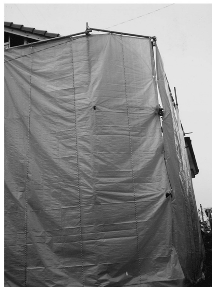
【仮設防災防止シート張現場】
