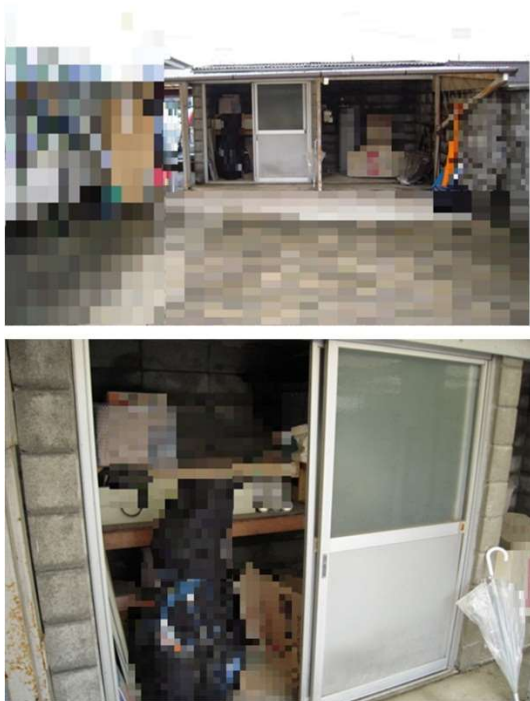
建物登記があるCB造倉庫
